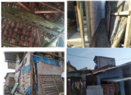
Gambar 8. Material Konstruksi Sumber : Dokumentasi Pribadi, 2019
