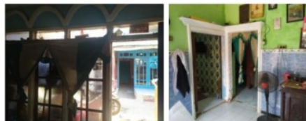
Gambar 2. Kondisi Rumah Warga Sumber : Dokumentasi Pribadi, 2019
