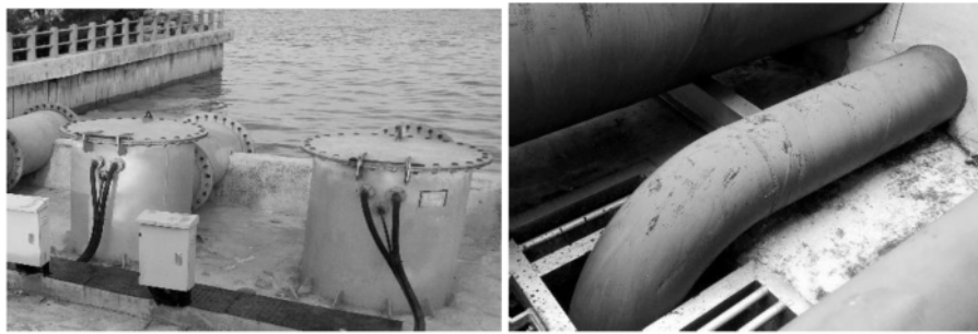
Gambar 4. Rumah pompa akan memiliki 2 jenis pompa, yaitu air dan sludge untuk waste
