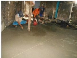
Gambar 10. Perbaikan Dapur UD. Dedi Jaya
